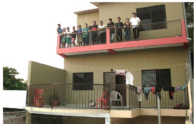
Studierendenwohnheim in San Francisco Gotera Quelle: Consciente Projektbericht 2019
